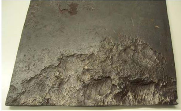
実機タンク底板、切り出しサンプル
